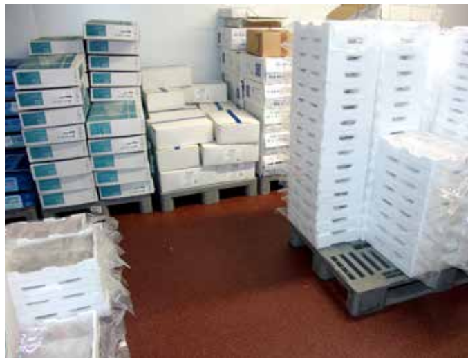
Die MMA-Beschichtung kann auch bei Frosttemperaturen wie hier im TK-Rohwarenlager verarbeitet werden.
