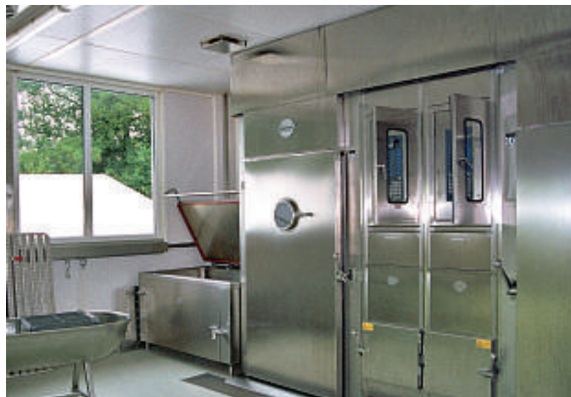
Für den neuen Maschinenpark und die gesamten Baumaßnahmen investierte der Fleischermeister rund eine Million Euro.
